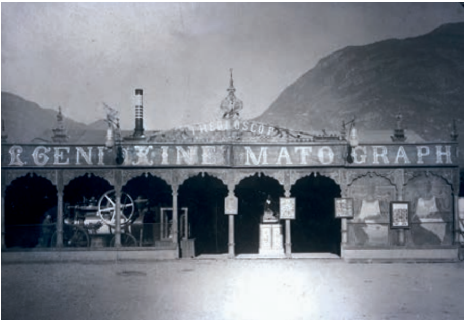
Wanderkino Louis Geni, links das Dampflokomobil zur Stromerzeugung, um 1905
