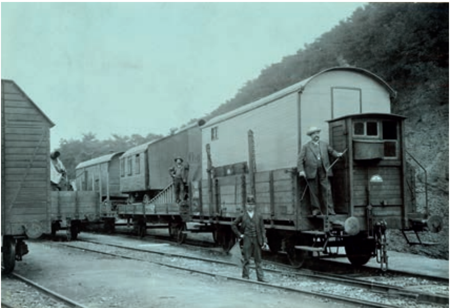
Auf Bahn verladene Schaustellerwägen des Wanderkinos, rechts vorne Louis Geni, um 1908
